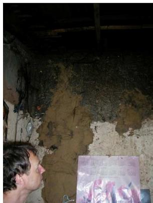
Das Dach war verrottet und völlig undicht, die Wände nass und verschimmelt, der Lehmfußboden bei Regen matschig.
